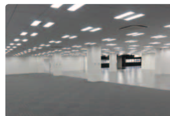
本社新社屋(北館)LED設置の様子
