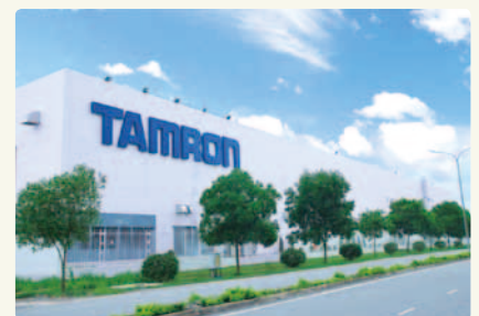
ベトナム工場外観
